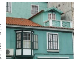
RUA VASCO DA GAMA
