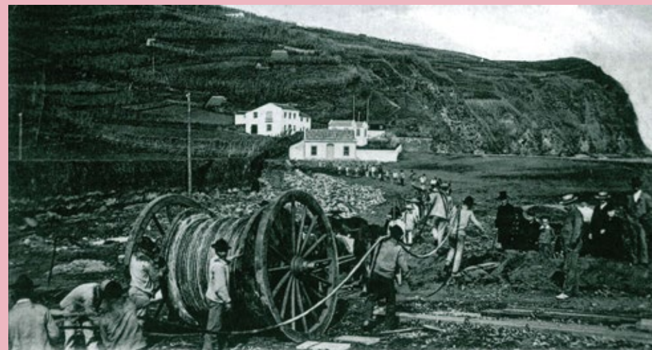
Lançamento de um cabo telegráfico submarino na Alagoa, 1904.
